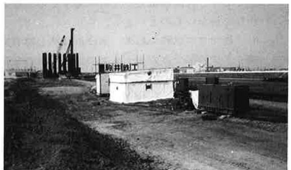
写真-1 試験場全景
