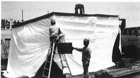
写真-3 風防設備組立
