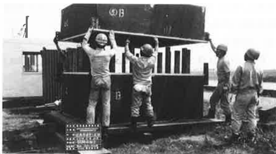
写真-2 試験体上部吊込
