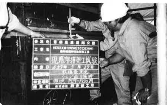
写真-7 変形量測定
