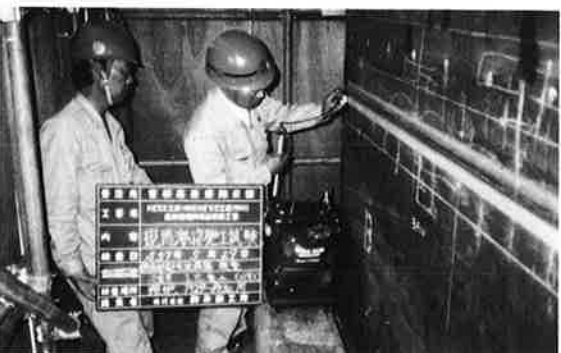
写真-8 隅角部超音波探傷試験
