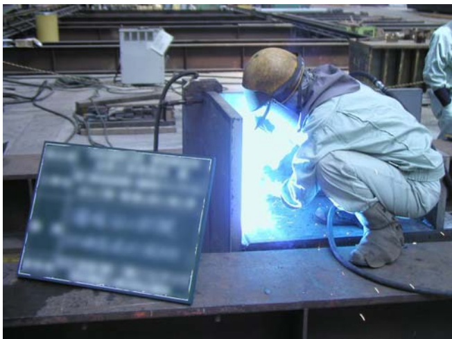
写真-2 溶接技量試験
