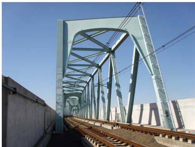
写真-1 江戸川橋りょう全景
