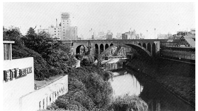
図-2 改修直前(昭和の終わり)の聖橋
