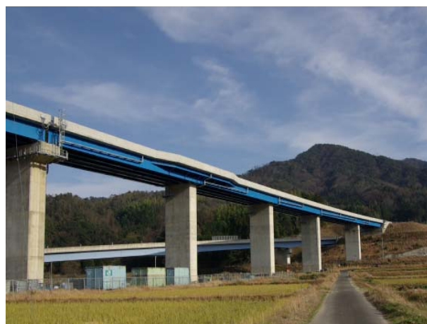
写真-9 施工完了
