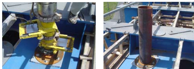
写真-5 コンクリート注入口および排出口
