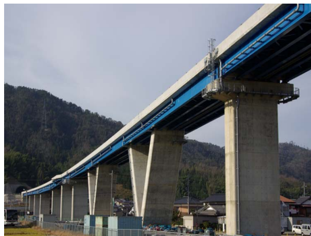
写真-8 施工完了
