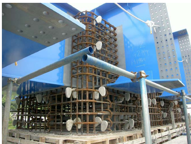
写真-4 剛結部配筋状況
