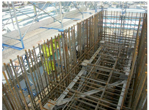
写真-2 剛結部横梁架設前の橋脚天端配筋と受台
