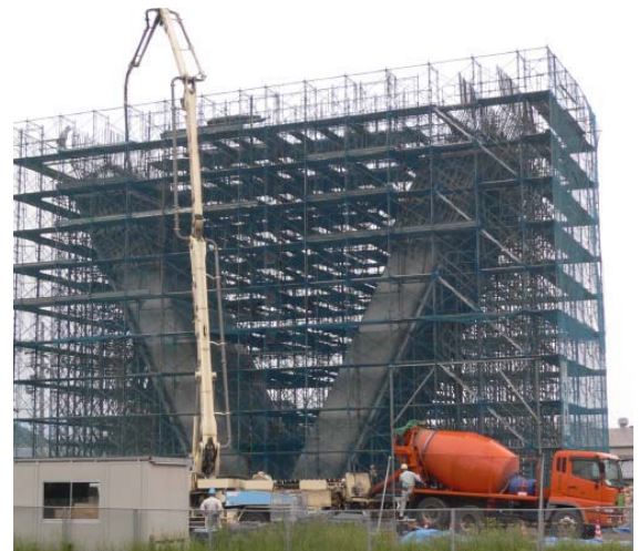
写真-1 コンクリート打設状況
