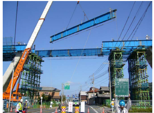
写真-7 府道通行止めが伴う架設状況
