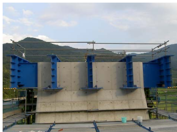
写真-6 剛結部施工完了
