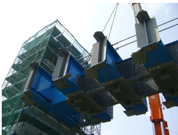
写真-3 剛結部貫通鉄筋用孔の配置状況
