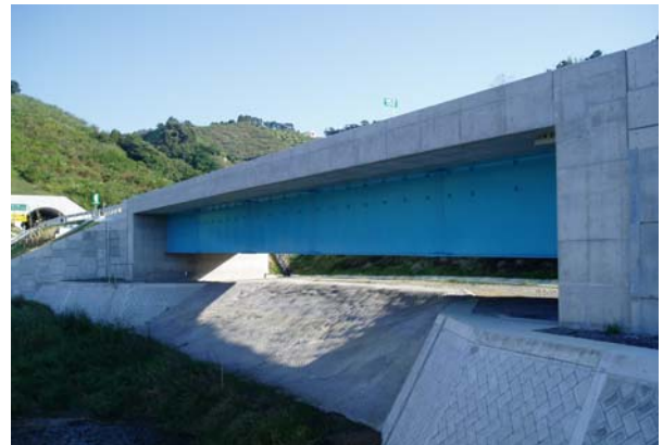
写真-1 橋梁全景
