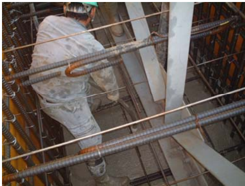
写真-2 橋台縦壁コンクリート打設状況
