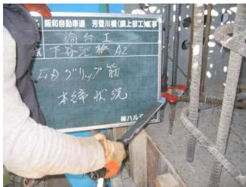
写真-3 橋台縦壁内部での鉄筋機械式継手
