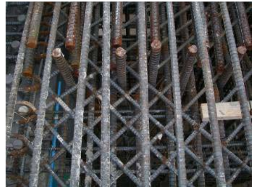
写真-4 堅壁主鉄筋と床版鉄筋、せん断補強鉄筋の配筋状況
