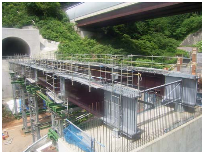
写真-2 鋼桁端部
