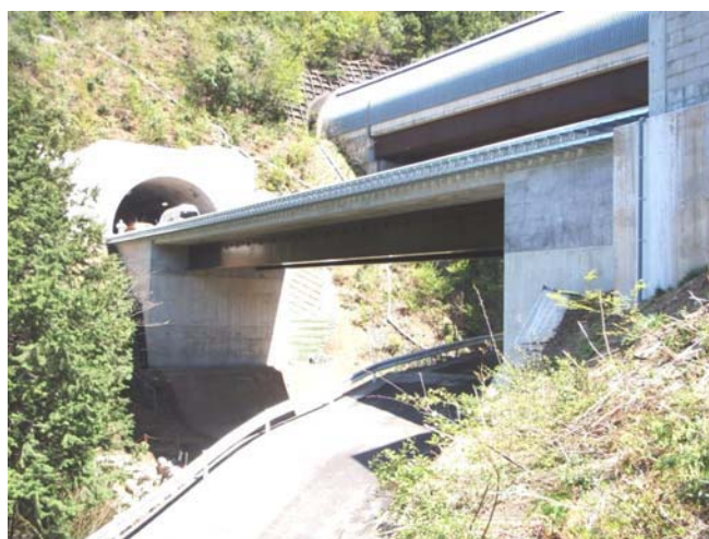
写真-5 施工完了
