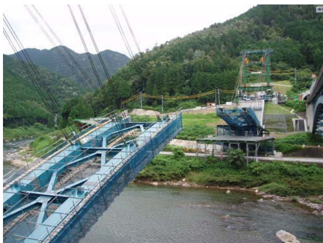
写真-4 アーチリブ斜吊り架設
