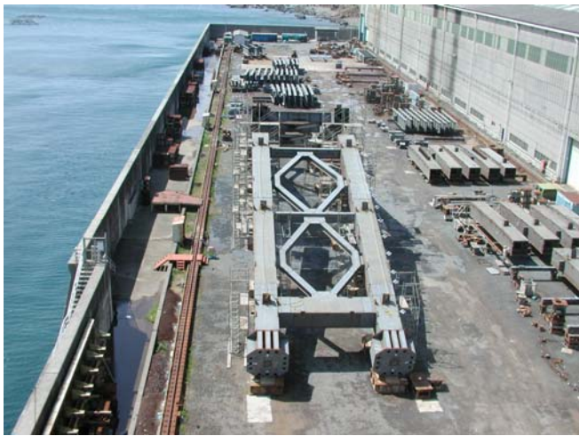
写真-2 アーチリブ分割仮組立
