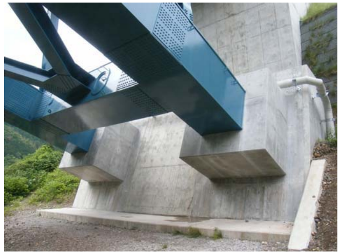
写真-5 アーチリブ基部
