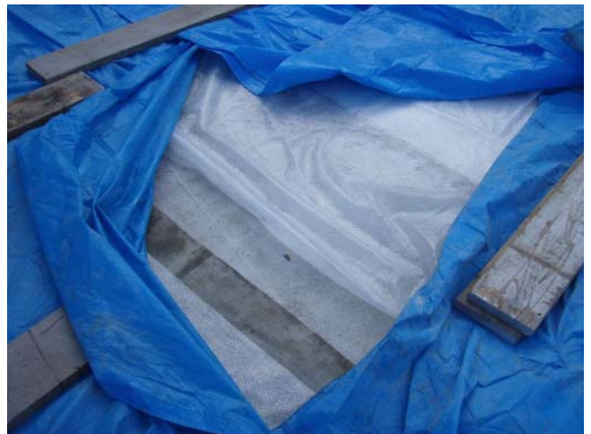
写真-6 床版コンクリート養生
