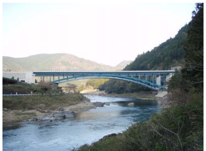
写真-7 完成写真（手前が本橋，後方が一期線）
