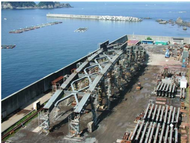
写真-3 アーチリブ分割仮組立
