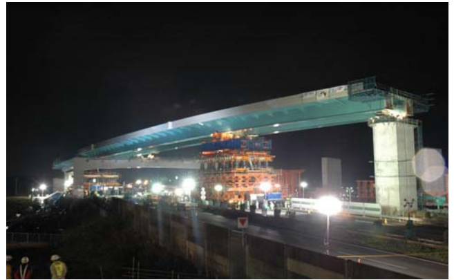
写真-5 自走台車による運搬完了直後の BP7～BP9 区間鋼桁
