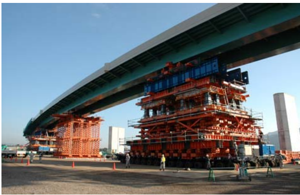
写真-4 自走台車全景（手前より後方台車/前方台車）
