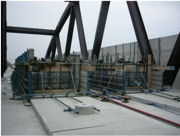
写真-7 静的荷重載荷状況
