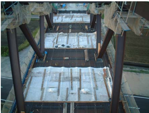
写真-5 段階打設状況
