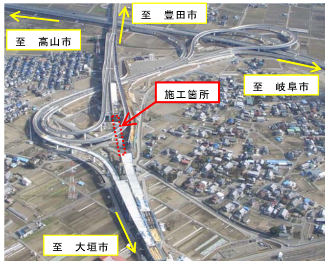
写真-1 美濃関ジャンクション全景(写真提供：国土交通省)
