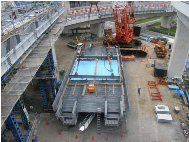
写真-4 大ブロック架設重機および地組桁配置状況
