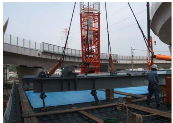
写真-3 一括架設吊天秤設置状況
