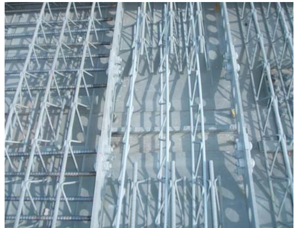
写真-2 合成床版パネル吊ピース切断後補強
