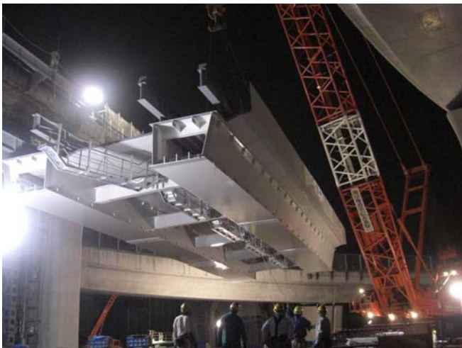
写真-5 桁吊上げ状況
