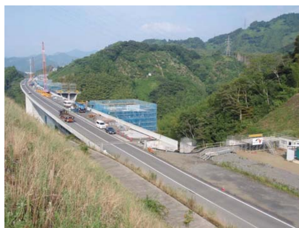
写真-13 巴川橋 (H20. 8)
