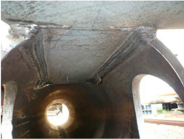
写真-5 管内側溶接
