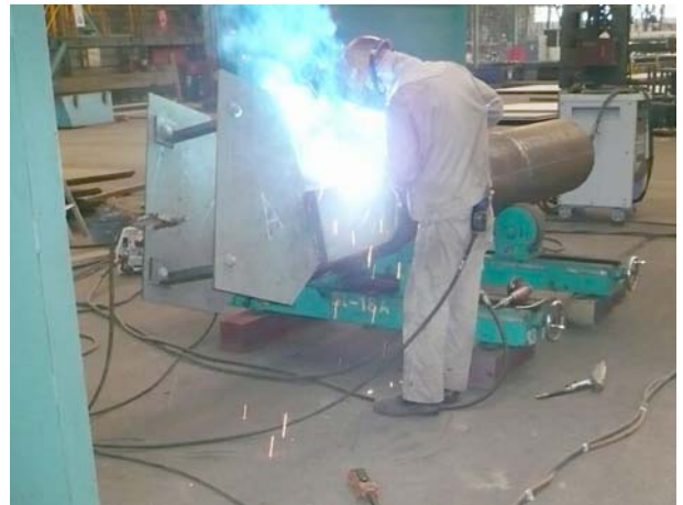
写真-3 溶接状況 (管外側)
