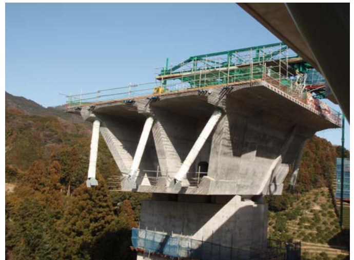
写真-1 現場施工状況
