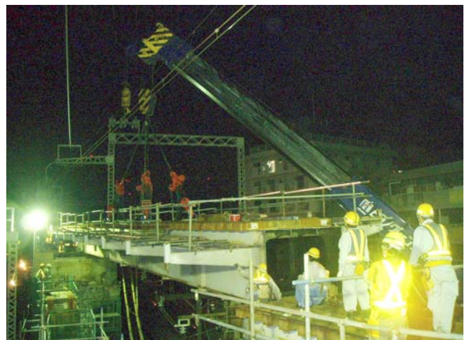
写真-2 撤去中の既設桁（A1～P2'）
