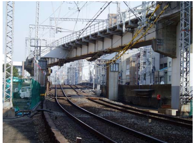
写真-1 撤去前の既設桁（天満橋側より）
