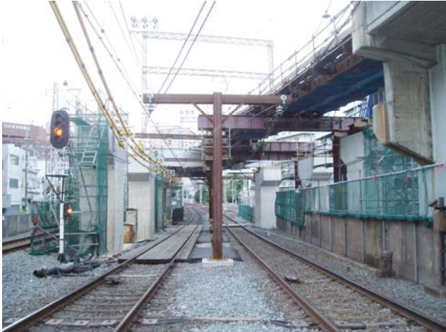
写真-3 仮桁および仮橋脚
