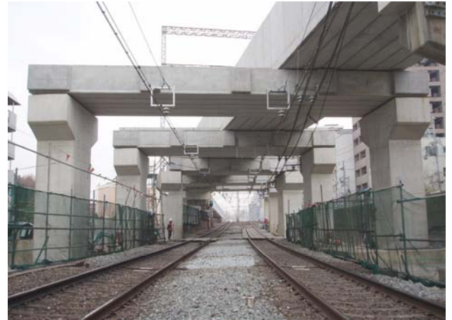
写真-4 RC 橋脚および PC 桁
