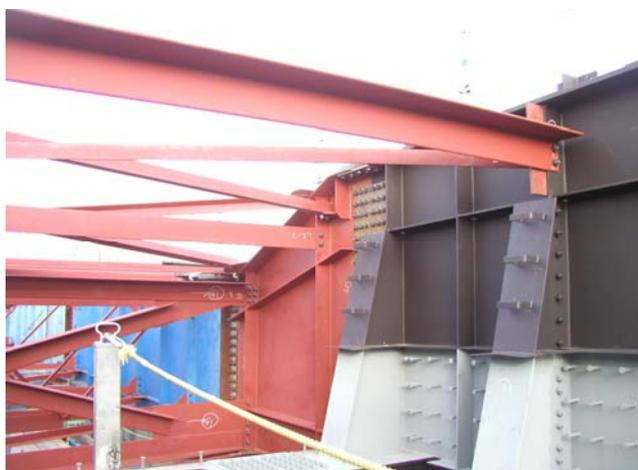
写真-1 連結構と上横構
