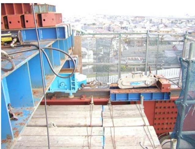
写真-2 最後部逸走防止構造
