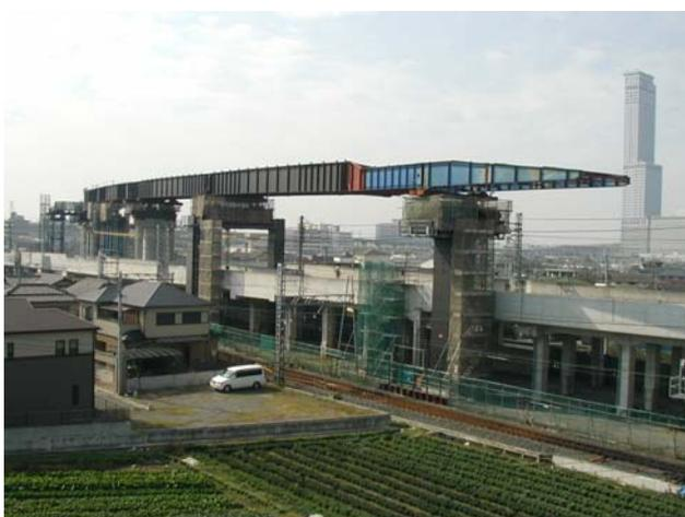
写真-4 送出し架設中の全景
