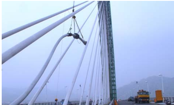
写真-7 再生し架設されるケーブル
