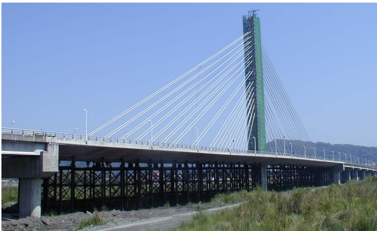
集鹿大橋全景（施工中）
