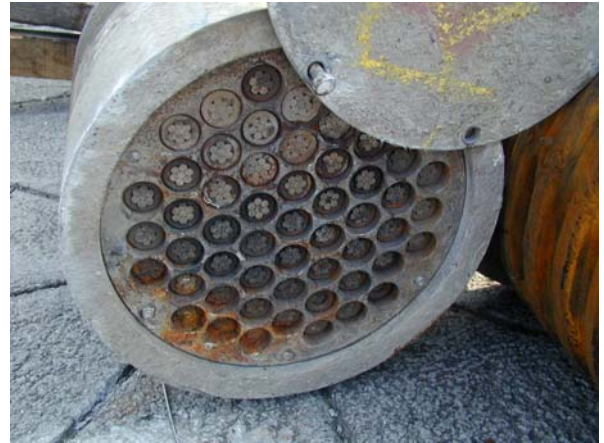
写真-2 既設ケーブルのソケット端部
