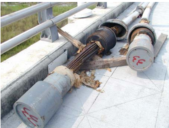
写真-1 既設ケーブルのソケット
