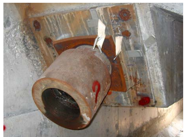
写真-3 既設ケーブルのアンカー部
