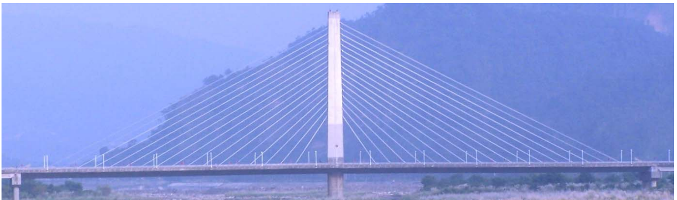
写真-8 修復の完了した集鹿大橋
