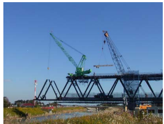
写真-6 張出し架設状況
