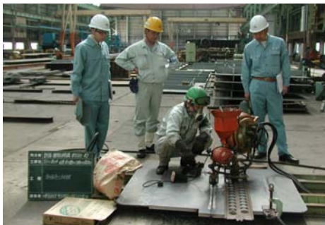
写真-1 Ni 系高耐候性鋼材溶接施工試験状況
