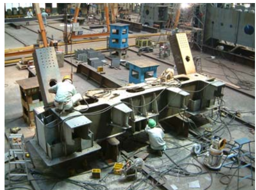
写真-3 端 支 点 部 製 作 状 況
