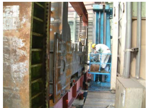
写真-4 端 支 点 部 製 作 状 況
