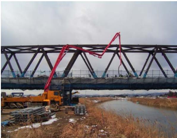
写真-7 コンクリート打設状況
