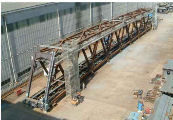
写真-5 仮組立状況
