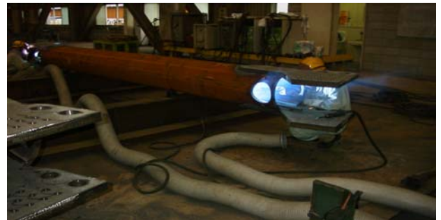
写真-3 二面ガセット溶接状況
