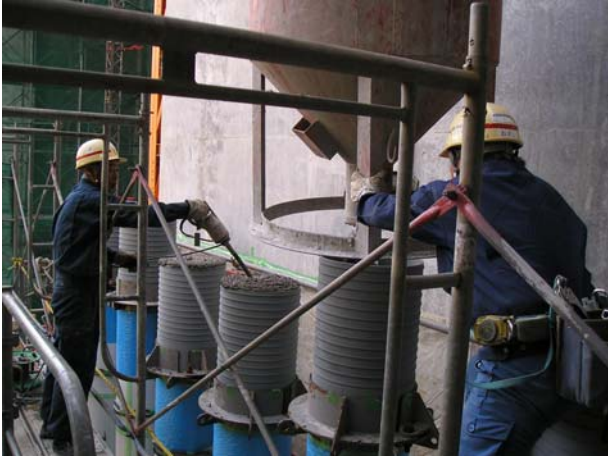
写真-10 トラス下部コンクリート逆さ打ち
