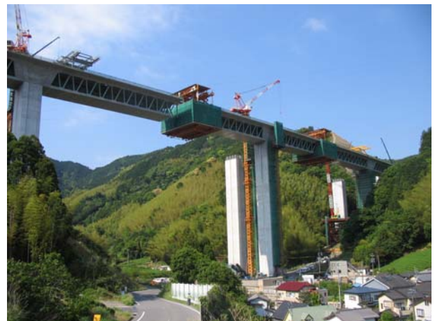
写真-9 移動作業車による張出し施工
