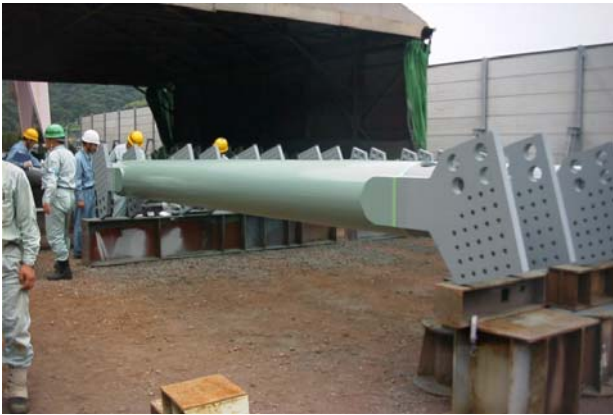
写真-5 二面ガセット格点構造
