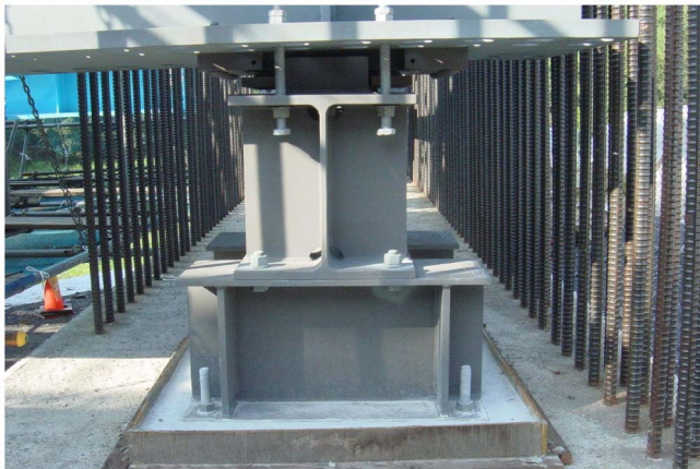
写真-1 仮支点構造
