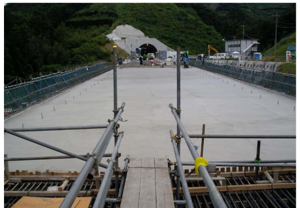
写真-5 剛結部を残してPC床版を施工
