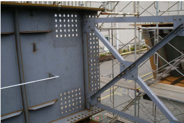
写真-2 桁端部構造（仮組時）
