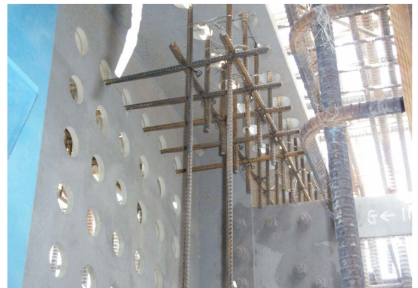
写真-6 フランジのジベル部の貫通鉄筋
