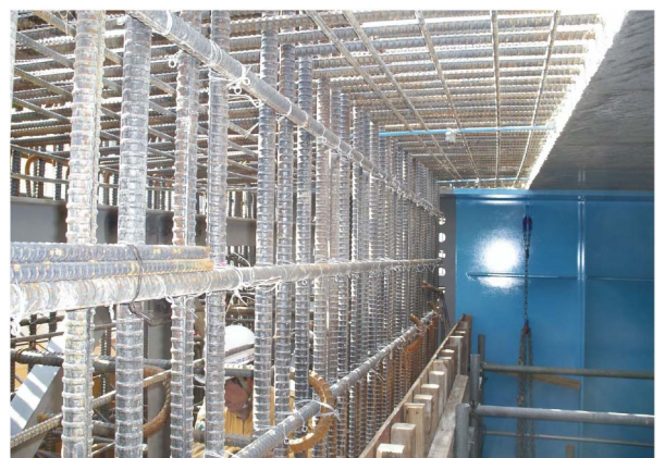
写真-7 剛結部配筋状況
