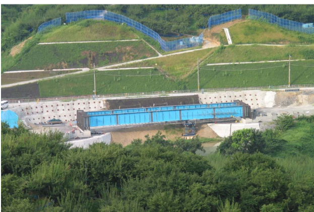
写真-3 架設完了時
