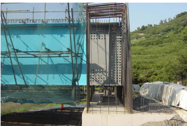
写真-4 剛結部（架設完了時）
