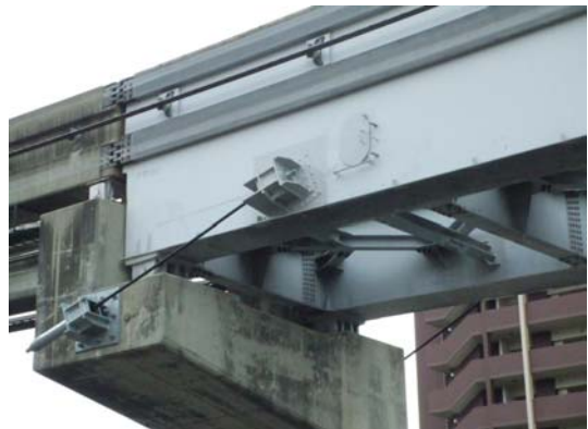
写真-3 落橋防止装置設置完了
