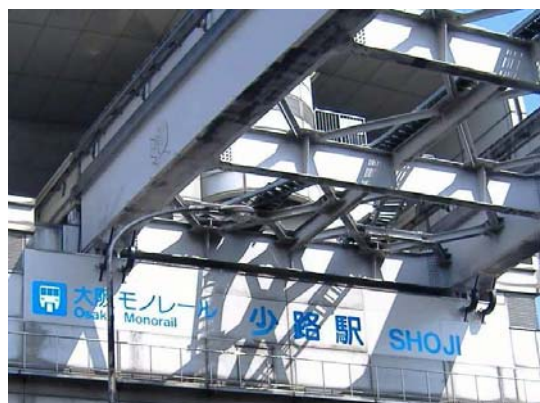
写真-4 落橋防止装置設置完了
