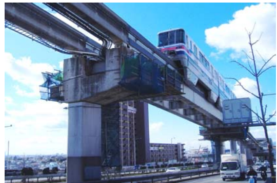
写真-2 足場設置状況
