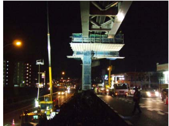
写真-1 両側車線規制を伴う夜間作業状況 (左側:中国自動車道, 右側:大阪中央環状線)
