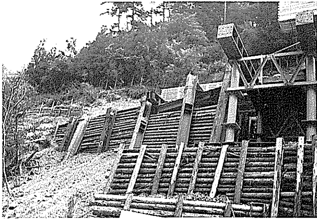
写真-4 ステージおよび搬入路補強
