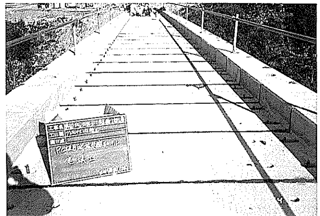
写真-5 無収縮モルタルの施工状況
