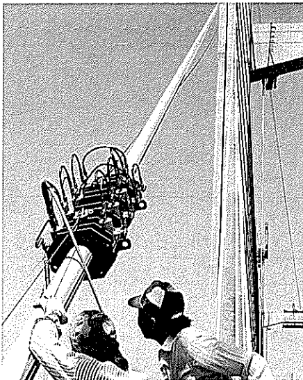
写真-3 アルミカバー装着ジャッキ
