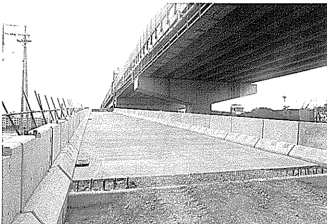
写真-4 PC床版・PC高欄の完成状況
