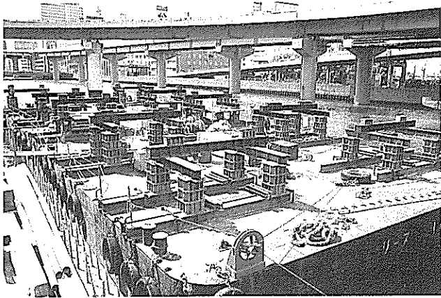
写真-2 支保工組立状況
