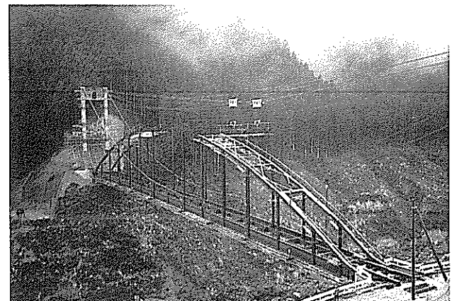
写真-7 垂直材、アーチリブの架設
