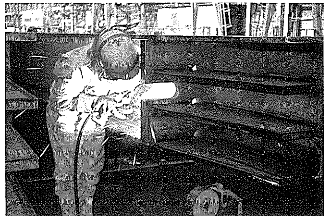
写真-2 引張材(定着部)の溶接状況
