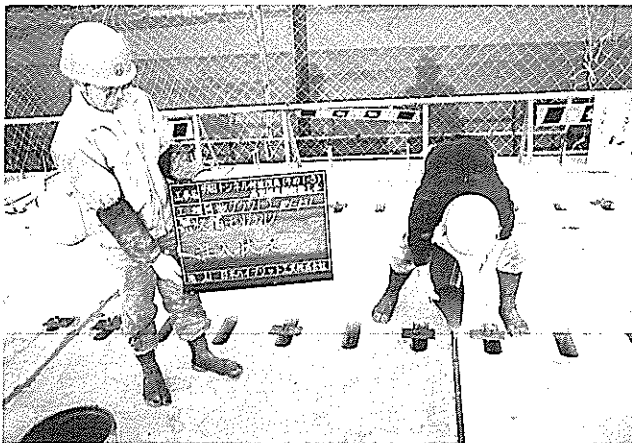
写真-3 継目の施工
