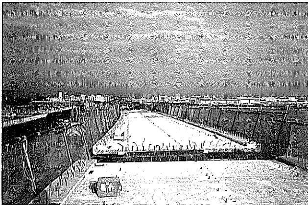
写真-13 連続H形鋼橋のPC床版
