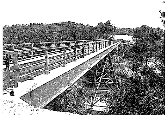
写真-14 5径間連続V脚ラーメン橋
