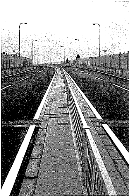
写真-12 連続合成箱桁橋の完成状況
