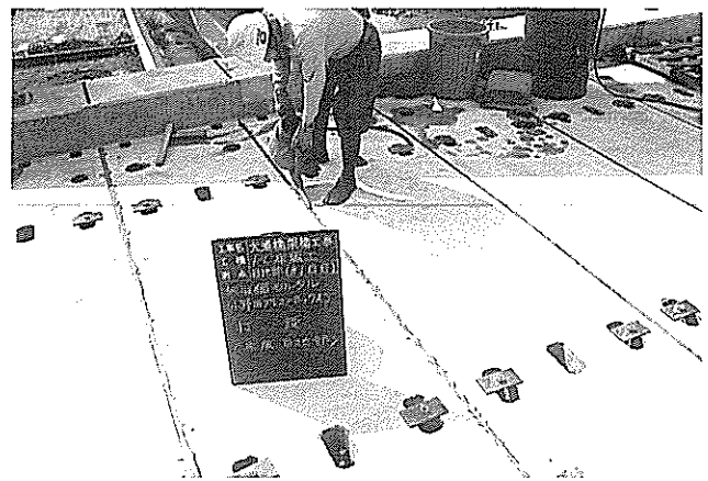
写真-7 PC床版の継目の施工
