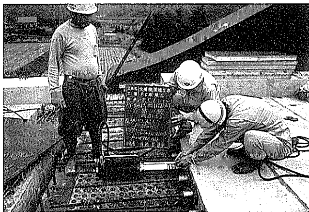
写真-8 橋軸方向プレストレスの導入
