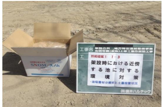
スノムはマメ科の植物殻が原料で、油を分解・消化する天然の微生物から来ています。見た目はおが屑のように粉末状となっており、右写真のように土嚢の隙間等につめて使用します。生分解性油吸着材・土壌浄化剤として使われ、高性能かつ自然に優しい製品です。スノムの特徴は、特殊なカプセル構造に油分だけを閉じ込めるので油の再流出がなく、撥水性に優れ、水を吸わず油のみを吸収します。安全性はACC（米国承認機関）がクラスAと安全承認したバクテリアのみ使用しています。使用後は100%自然に帰ります。
