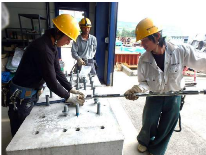
抜取り試験の様子
